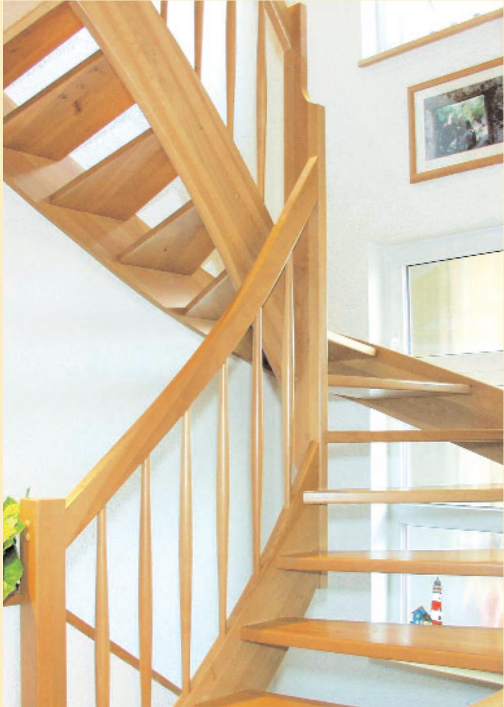
**E**ingestemmte Massivholztreppen sind zeitlos und schön. Bei Massivholztreppen verzichten wir auf Furnier und Spanplatten.
