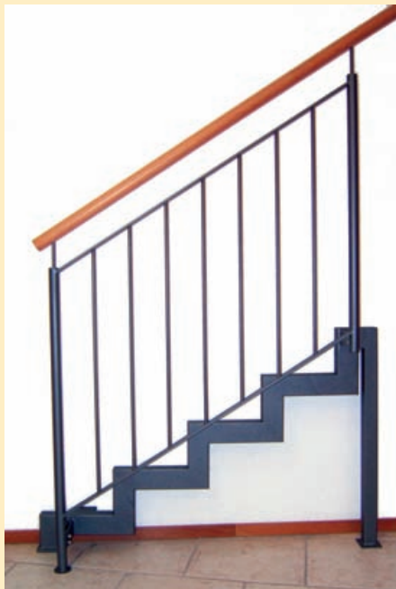
8: Obergurt und Untergurt aus Flacheisen 30x8 mm, senkr. Füllstäbe 12 mm, Handlauf aus Holz
