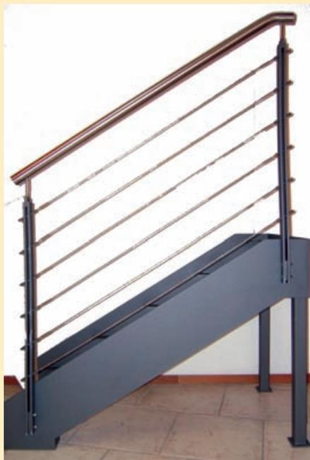
10: Pfosten aus T-Eisen, mitlaufende Füllstäbe 12 mm, Handlauf aus Rundrohr
