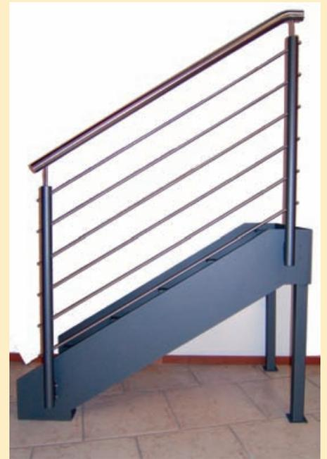
9: Pfosten aus Rundrohr 32 mm, mitlaufende Füllstäbe 12 mm, Handlauf aus Rundrohr 32 mm
