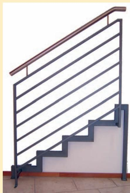
4: Obergurt und Untergurt aus Quadratrohr 20x20 mm, mittlere Füllstäbe aus Quadratrohr 20x20 mm, aufgesetzter Handlauf Rundrohr
