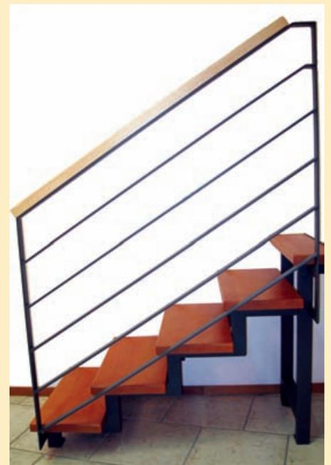
12: Obergurt und Untergurt aus Flacheisen 40x8 mm, mitlaufende Füllstäbe aus Flacheisen 40x8 mm, mit aufgesetztem Holzhandlauf 40x40 mm
