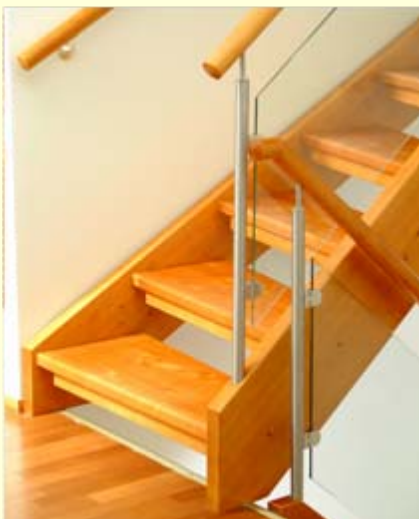
Podest-Treppe, eingestemmt offen, Buche massiv 50 mm mit Stufenleisten Handlauf HKR 50 Pfosten Edelstahl mit Glasfüllung
