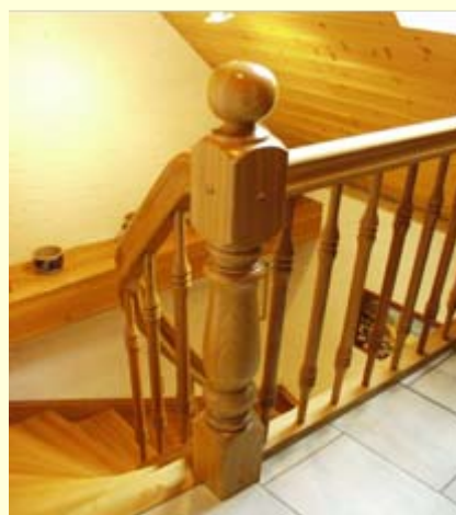
Treppe 2x1/4 gewandelt, ein- gestemmt offen in Eiche massiv 60 mm mit Krümm- lingen Handlauf Omega Pfosten HTS 2 120 mm
