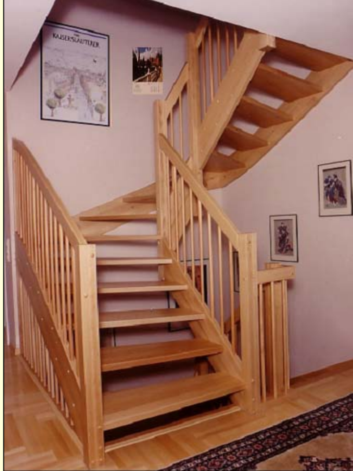
Treppe 2x1/4 gewendelt, eingestemmt offen in Buche massiv 40 mm Handlauf HKM Pfosten HTK 80 Geländer HS 23
