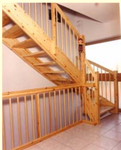
Treppe 1x1/4 gewendelt, eingestemmt offen, Kiefer massiv 40 mm Handlauf HKS Pfosten HTK Ge- länderstäbe HS 02
