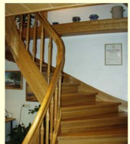
Treppe 2x1/4 gewandelt in Eiche massiv 60 mm eingestemmt geschlossen mit Stellstufen Geländer HS 02
