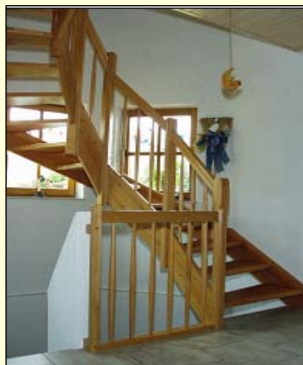
Treppe ½ gewandelt, eingestemmt offen, Buche 40 mm Handlauf HKS Pfosten HTK Geländer HS 38
