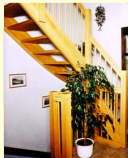
Treppe 1x1/4 gewendelt, eingestemmt offen, Buche massiv 40 mm Handlauf HKS Pfosten HTK Geländer HS 23
