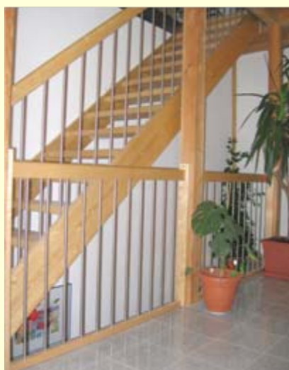
Treppe gerade, eingestemmt offen in Birke massiv 50 mm Handlauf HKP Pfosten HTK Geländer S1,Edelstahl
