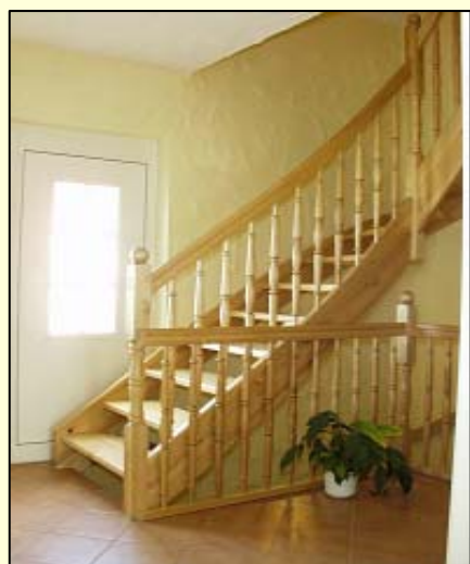
Treppe 1x1/4 gewendelt, eingestemmt offen in Birke massiv 40 mm Handlauf HKS Pfosten HTS 3 Ge- länder HS 02
