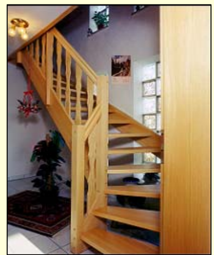
Treppe 2x1/4 gewendelt eingestemmt offen in Buche massiv 40 mm mit Latten- geländer Pfosten HTK 80
