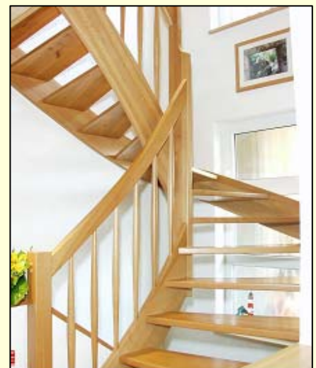
Treppe \frac{1}{2} gewendelt, eingestemmt offen in Buche massiv 40mm, Handlauf HKM Pfosten HTK 80 Geländer- stäbe HS 38
