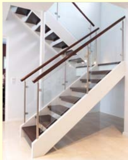
Podest-Treppe, eingestemmt offen, Birke massiv 50 mm Wangen weiß lackiert Stufen gebeizt, Handlauf HKR 50, Pfosten Edelstahl mit Glasfüllung
