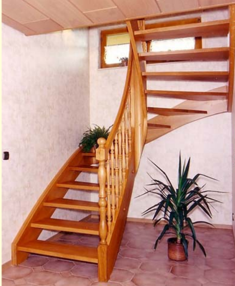
Treppe ½ gewendelt, eingestemmt offen in Mahagoni massiv 50mm mit Krümlingspfosten und gedrechselten Stäben und Pfosten
