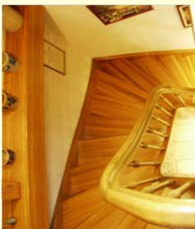
Treppe 2x1/4 gewandelt, eingestemmt offen in Eiche massiv 60 mm mit Wangen und Krümmlingen Handlauf Omega-Form
