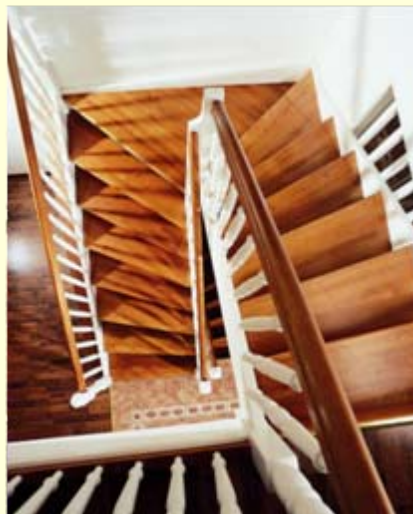
Podest-Treppe, eingestemmt, geschlossen, Wangen und Geländer weiß lackiert, Stufen und Handlauf Birke gebeizt
