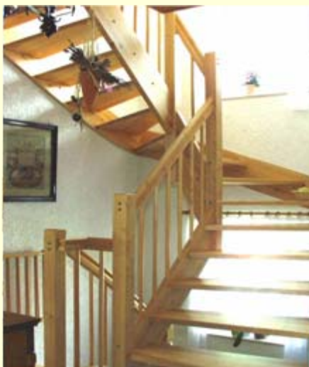
Treppe \frac{1}{2} gewendelt, eingestemmt offen in Buche massiv 40mm, Handlauf HKM, Pfosten HTK 80 Geländerstäbe HS 23
