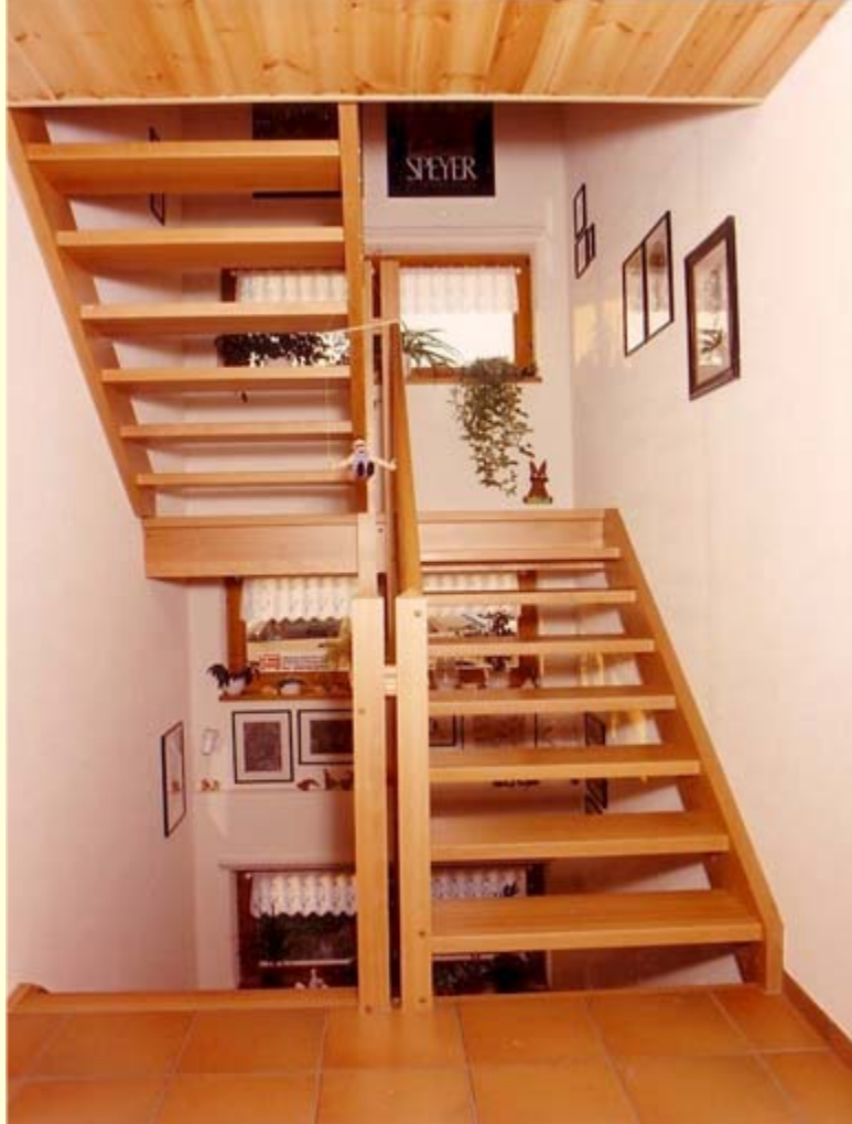
Podest-Treppe, eingestemmt offen, Buche massiv 40mm Handlauf HKP Pfosten HTK-P Geländer mit Latten
