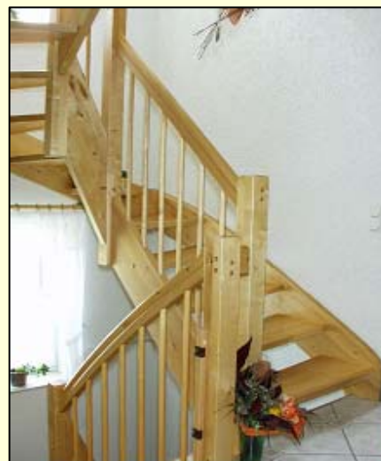
Treppe \frac{1}{2} gewendelt, eingestemmt offen in Buche massiv 40mm, Handlauf HKM Pfosten HTK 80 Geländer- stäbe HS 23
