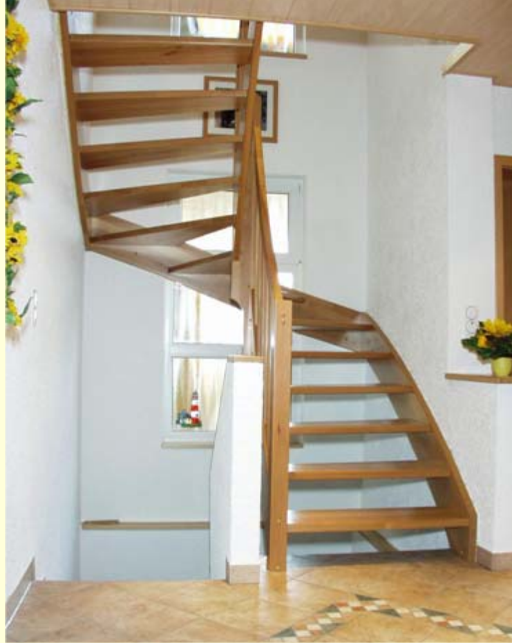
Treppe \frac{1}{2} gewendelt, eingestemmt offen, Buche massiv 40mm Handlauf HKM Pfosten HTK 80 Geländerstäbe HS 23
