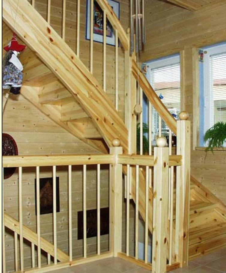
Treppe 1x1/4 gewendelt, eingestemmt geschlossen mit Stellstufen in Kiefer massiv 40 mm Handlauf HKS Pfosten HTK mit Kugel Geländer HS 23
