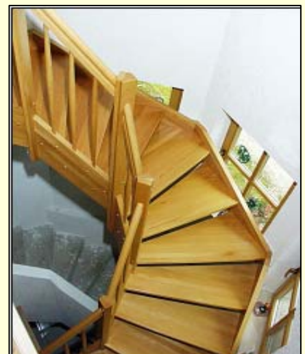
Treppe ½ gewandelt, eingestemmt offen, Buche 40 mm Handlauf HKS Pfosten HTK Geländer HS 38
